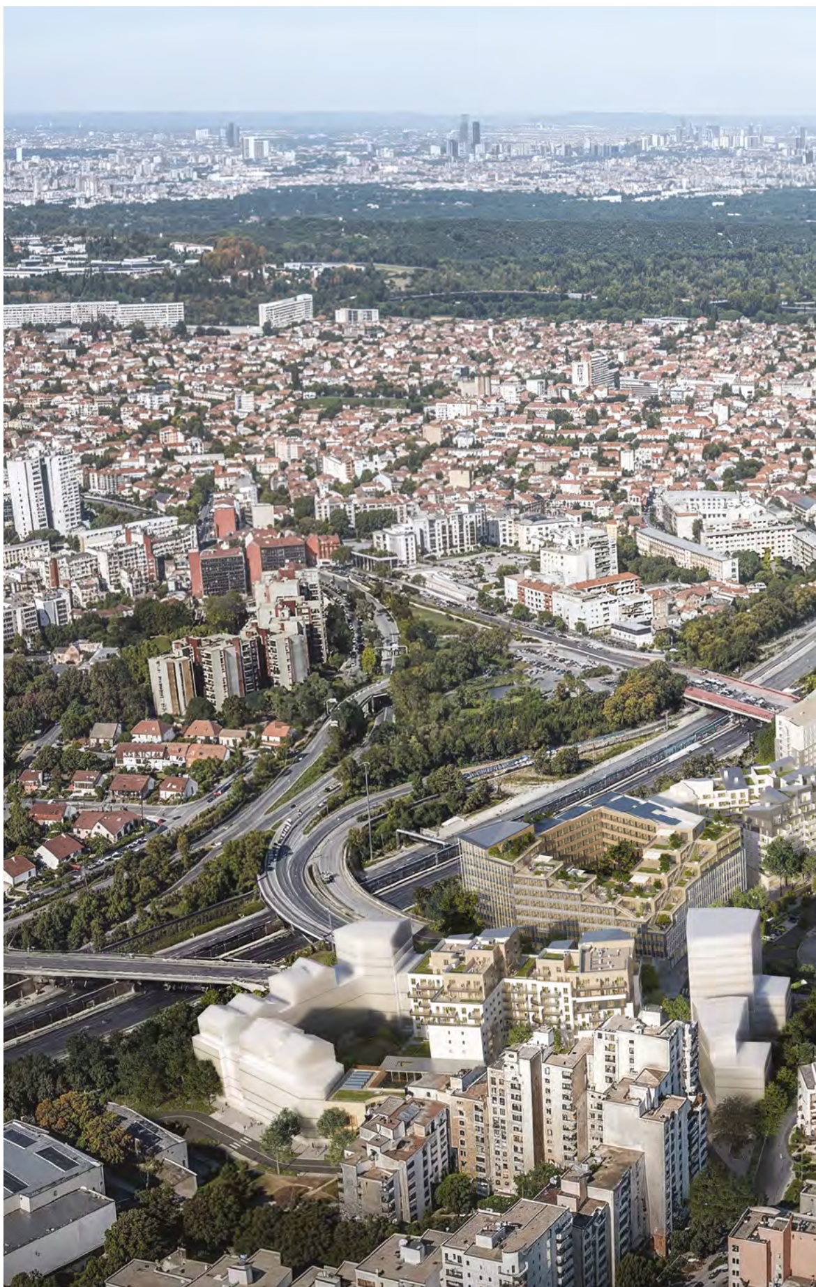
Vue aérienne du projet : © Architectures-Studio
