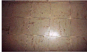
Dalles de sol
